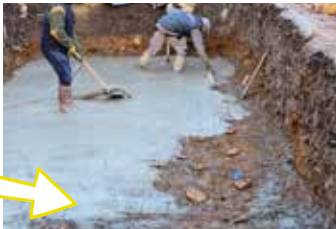
Le coulage de la dalle de fond ..... 19
